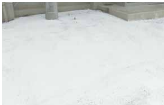
【消石灰】消石灰散布後はほうきなどで掃きムラをなくす
