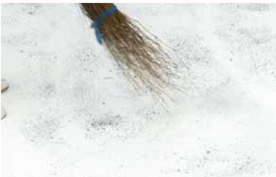
【消石灰】消石灰散布後はほうきなどで掃きムラをなくす
