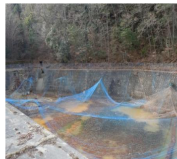
防鳥ネット設置 出典：家畜改良センター
